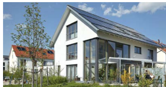
Foto: Sonnenhaus-Institut e.V.
